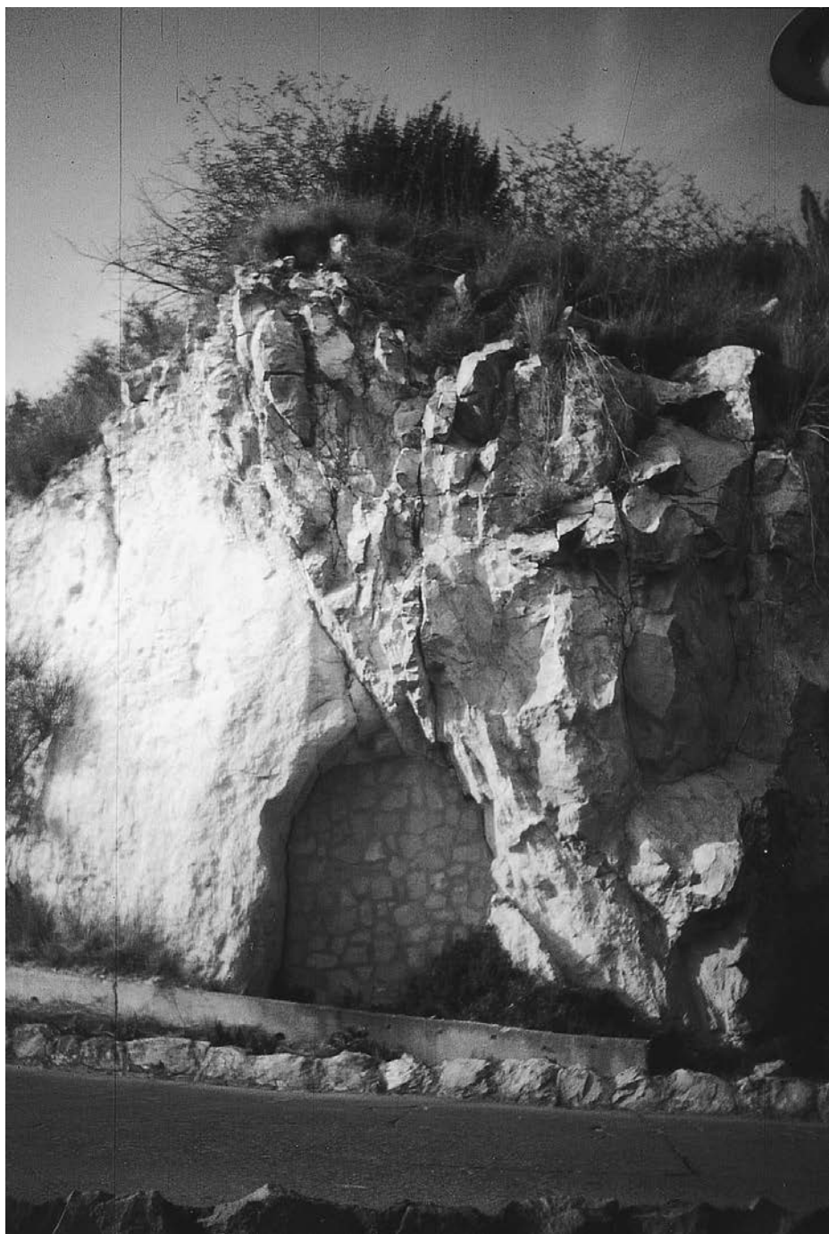
Fig. 1. Entrada, tapada, d'una antiga galeria al camí de baixada al CN Montjuïc.
